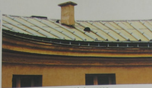
La toiture est traitée en cuivre et en plomb sur la zone formant le terrasson.
