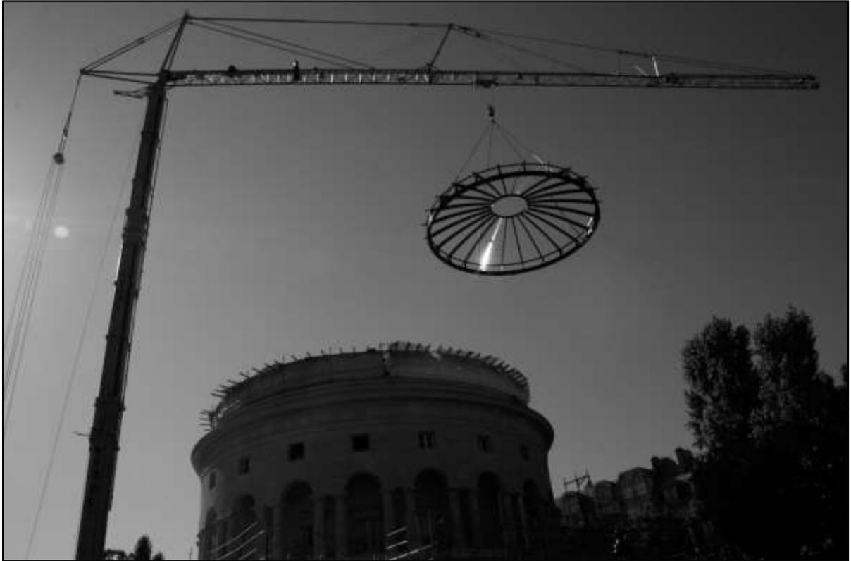
**Fig. 18 :** *Mise en place de la verrière au-dessus de la cour centrale de la rotonde.*
